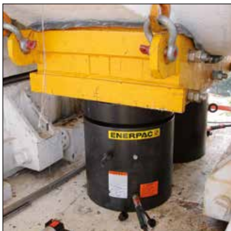
▲ Zvedání těžkých břemen a vyvažování základů. Pojistná matice zajišťuje mechanické držení břemene po dlouhou dobu.
