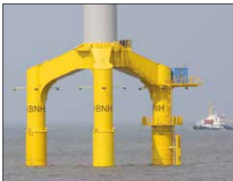
▲ Vyrovnávání větrných turbín na moři: Synchronní zdvihací systém Enerpac dodaný jako řešení pro vyrovnávání podpěrných nosníků 80 větrných turbín.
