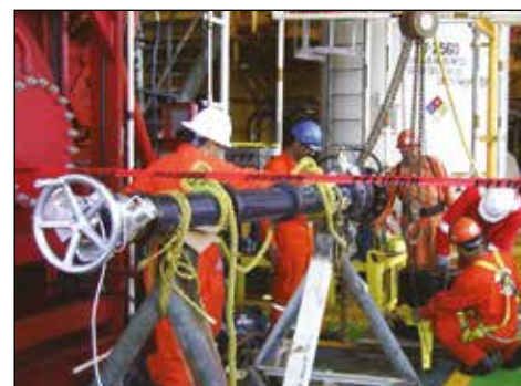
▼ Děrování spoje potrubí v námořním prostředí s použitím zařízení CHT2000.
