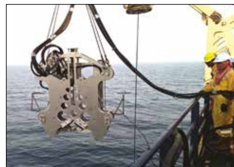
▲ Spouštění pily s diamantovým lanem řady MDWS do vody.
